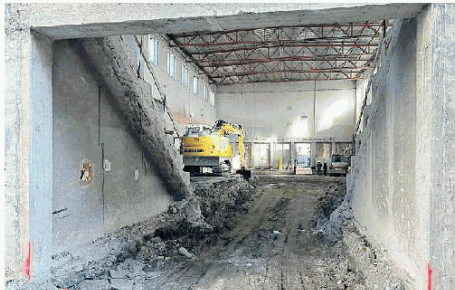
OPERE Entrano nel vivo i lavori nell'ex palazzetto in via Zanchi che entro marzo 2026 diverrà un centro culturale polifunzionale
